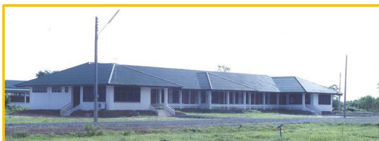
ภาพสำนักส่งเสริมการเรียนรู้ เดิม (อาคารชั่วคราว)
