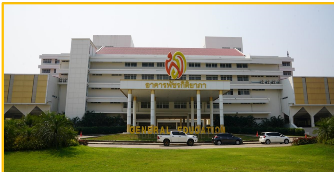
ภาพสำนักส่งเสริมและบริการวิชาการ อาคารพัชรกิติยาภา (อาคาร ๗)
