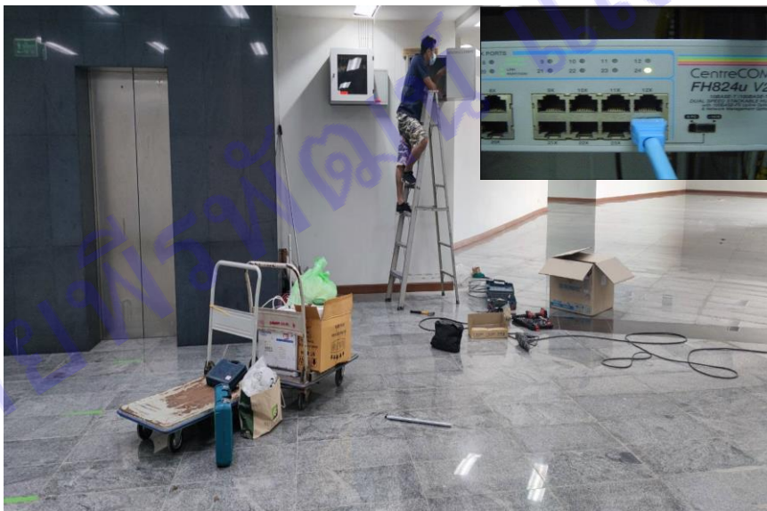
ภาพที่ 4.64 ติดตั้งตู้แร็ค และ switch hub
