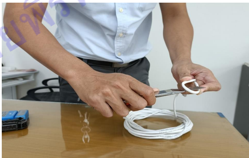
ภาพที่ 4.51 ตัดสาย LAN
